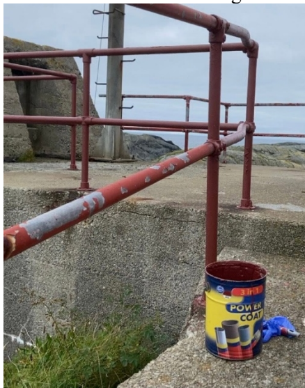
Soling etter utført arbeid, foto Norunn Kalgraff
