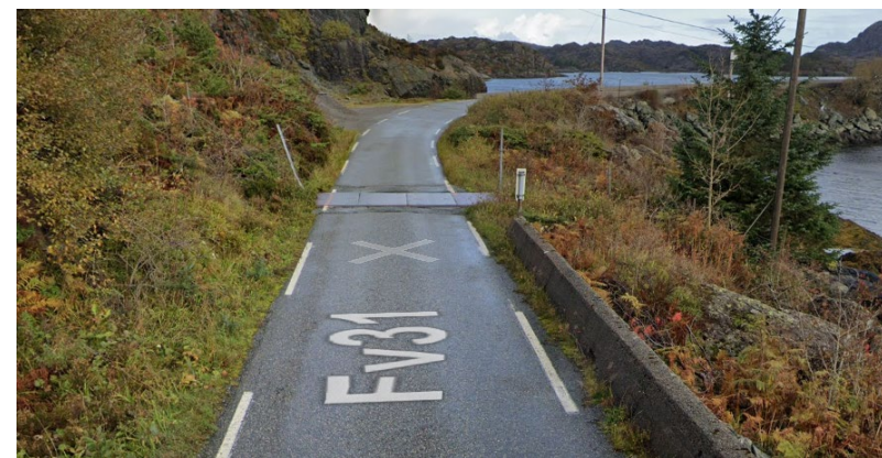
Figur 10. Ferist på vestsida av brua.
