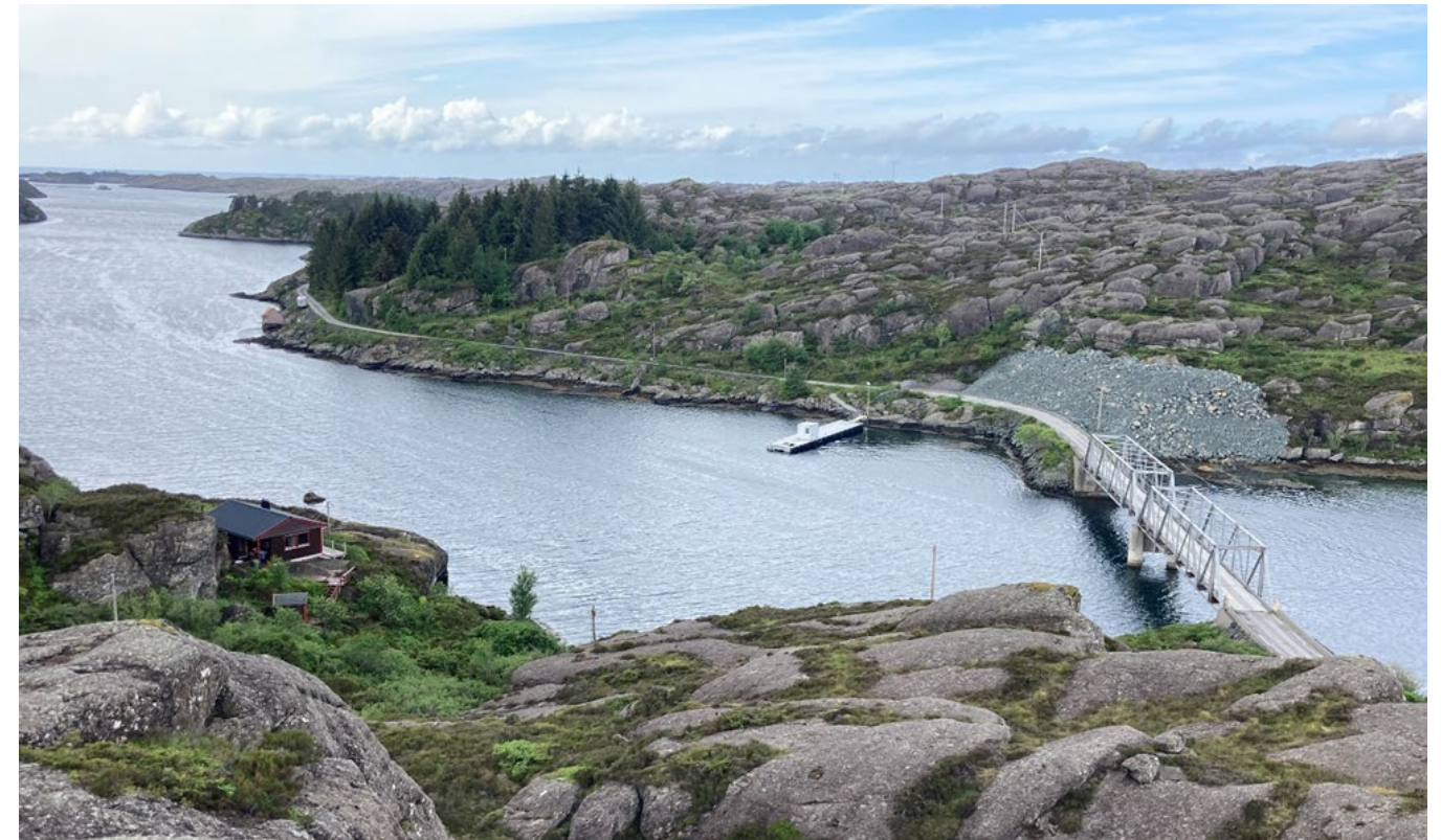
Figur 23. Overskotsmassar, 6000 m 3 , frå arbeidet med Ytre Steinsund bru er allereie lagra på vestsida av Rørdalsfjord bru.
