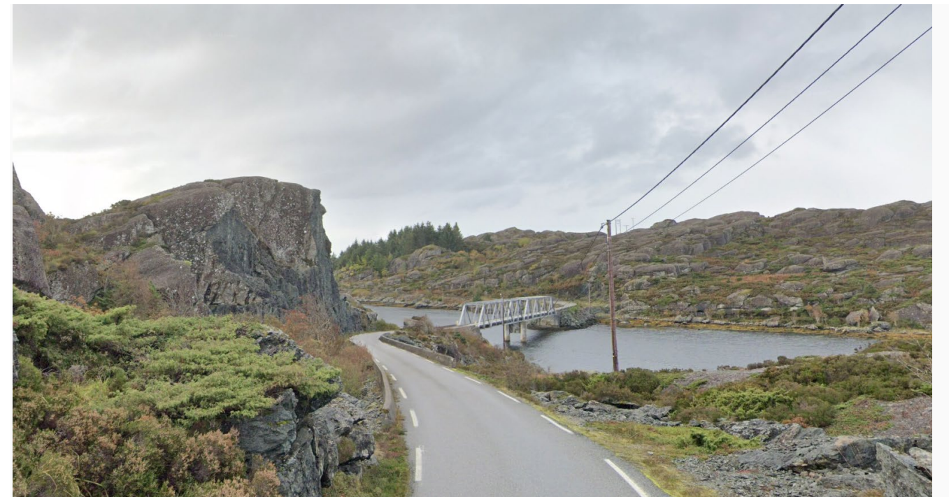
Figur 6. Foto av Nåravegen fv. 5591 og Rørdalsfjord bru frå nord-aust, (google.maps).
