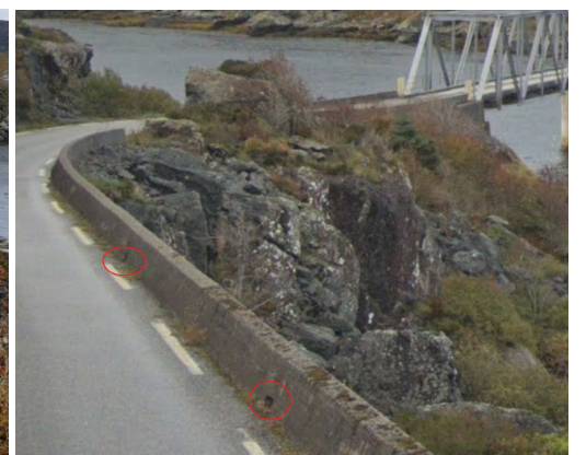
Figur 11. Dreneringshol gjennom betongautovern
