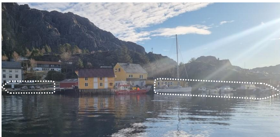
Figur 5-11 Indre hamn sett frå nordvest. Lokalisering for deler av flytekai til høgre og parkering/køyreareal til venstre (pilar indikerer at areala strekk seg utafor bildekanten).
