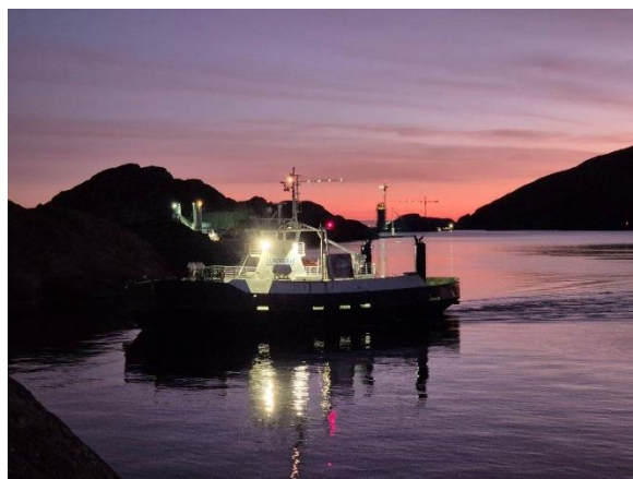
Sundferja med brubygging over Ytre Steinsund i bakgrunnen. Foto: Solund kommune – Anne Kristine Dyrdal.
