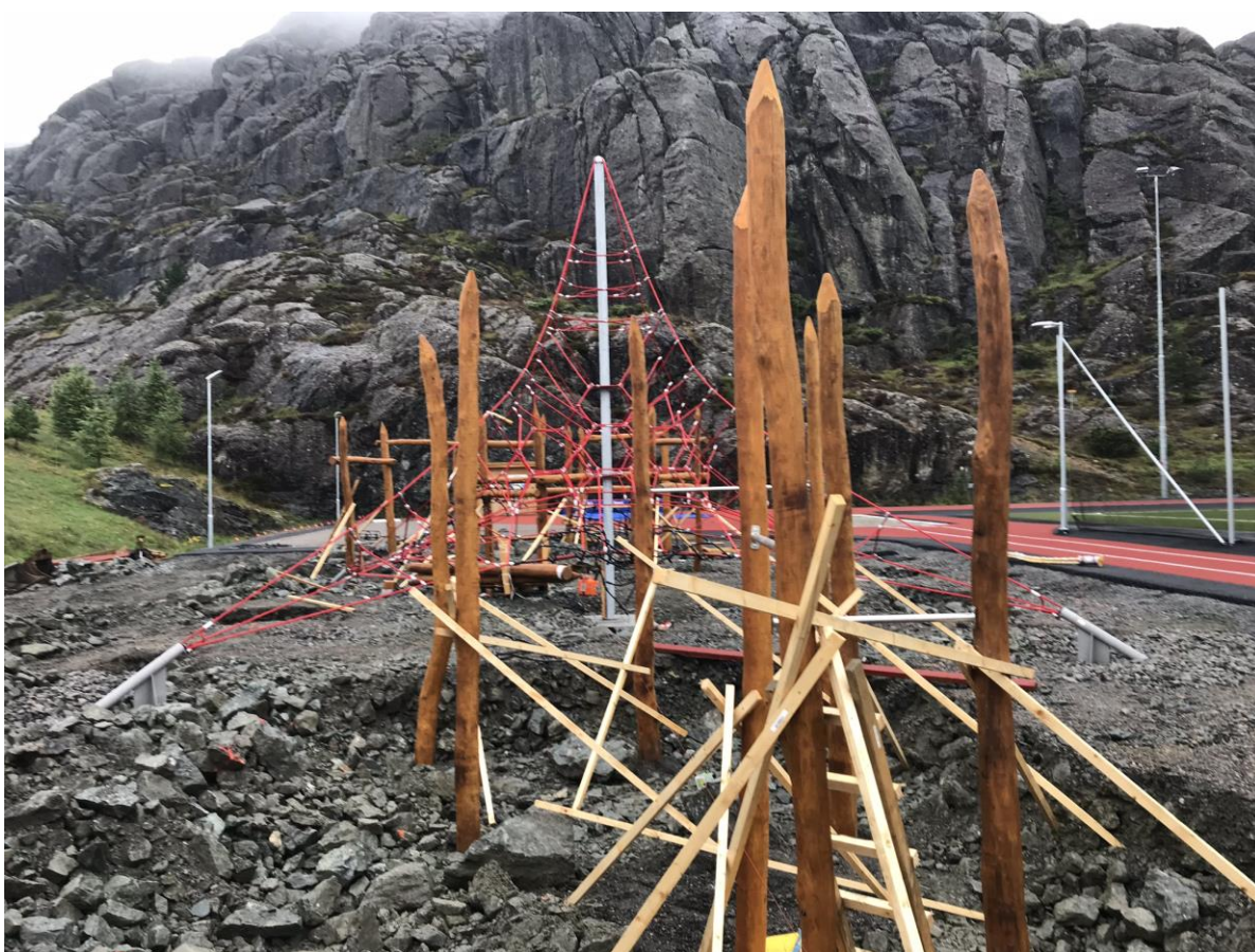
Full rulle med installasjon av Klatreparken
